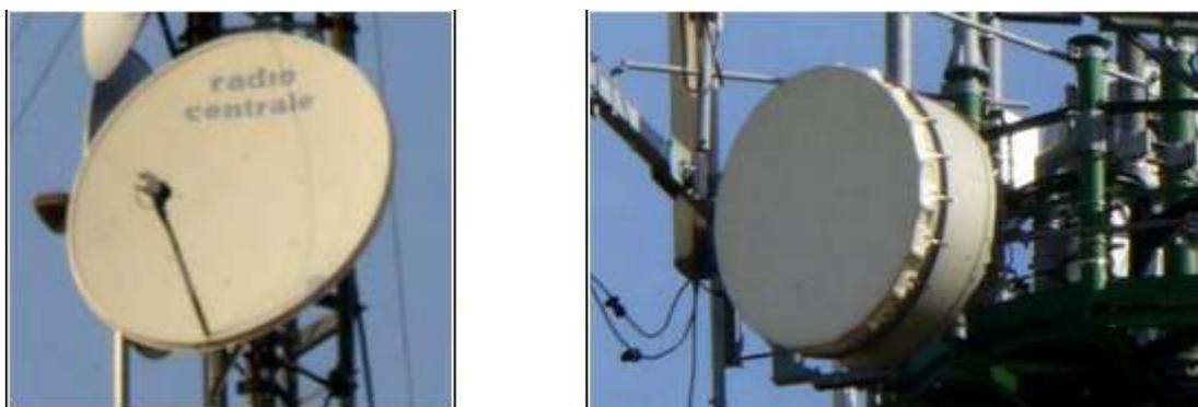
Figura 8: esempi di ponti radio di antenna radio e di ponte radio di Stazione Radiobase
